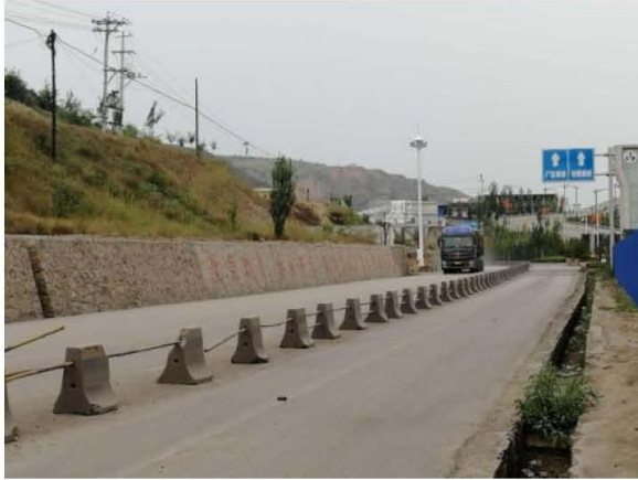
项目门口道路
